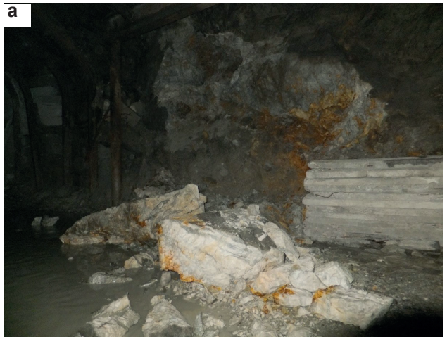
Рис. 2. Обрушения по контактам напластования раздробленных пород на кровле горных выработок с захватом левой стенки
